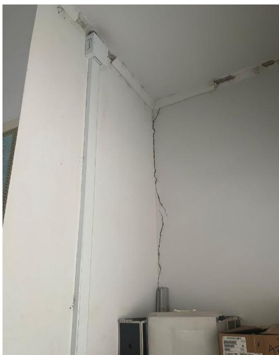
Figura 3 – Trinca presente no encontro de paredes
