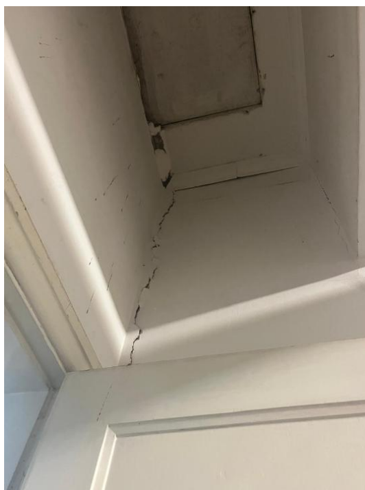
Figura 4 – Trinca presente no encontro de paredes
