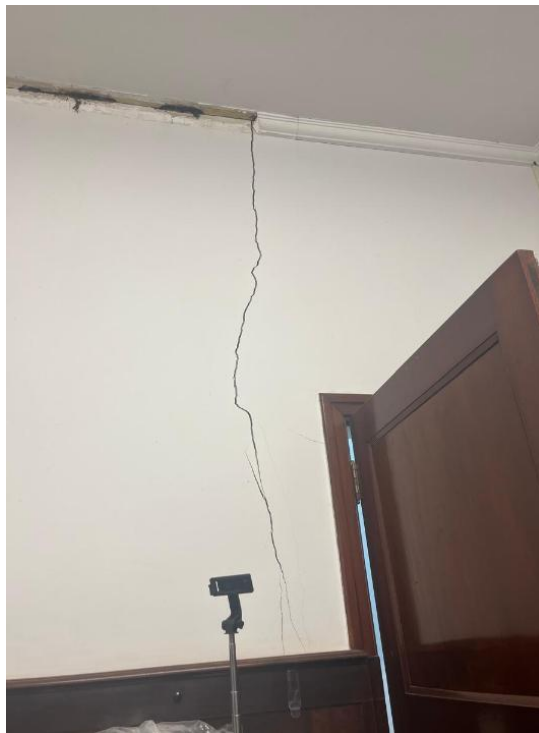
Figura 1 – Trinca ao longo do comprimento da parede
